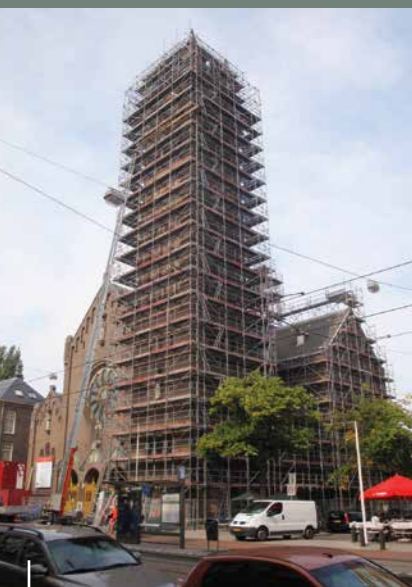
De toren in restauratie, september 2013.
